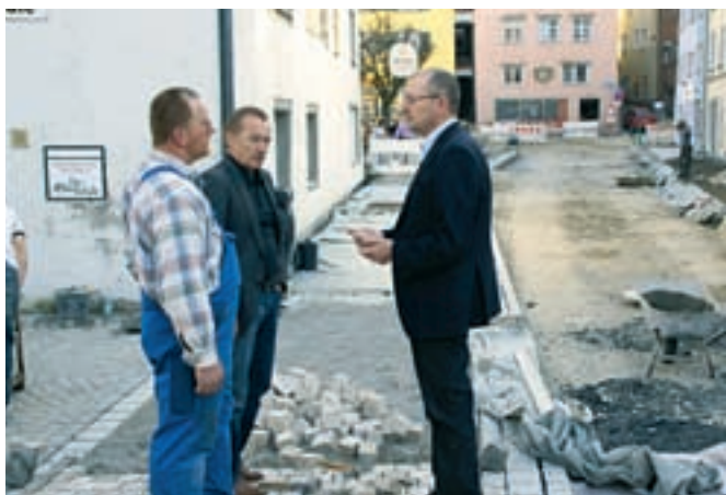
Mit Stadtrat Gebhard sah sich OB Dr. Ecker das Fortschreiten der Bauarbeiten am Alten Schulplatz an. Aufgrund der maroden Infrastruktur mussten alte Leitungen ausgetauscht werden. BZ-Foto: Winfried Hamann
